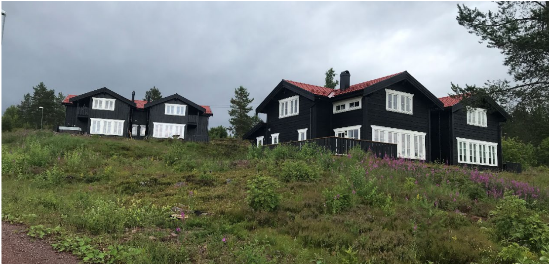
Relativt nybyggda parhus i norra Toppbyn.
